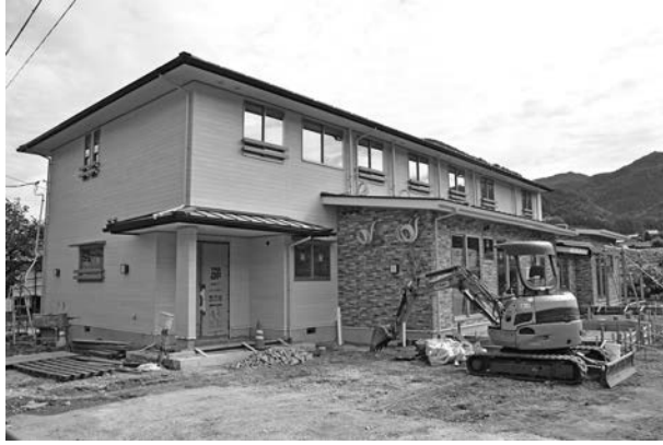
現在建設中の津和野町交流センターひまわり
