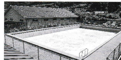
改修されるプール
