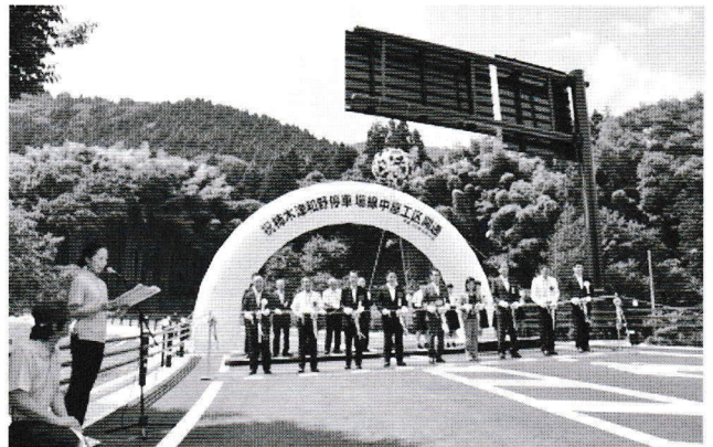
開通した中座バイパス(平成30年)
