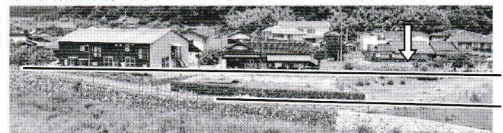
川丁無堤防区間100m 高低差2m 石積 長さ20m 幅3m
