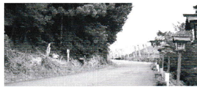
⑤町道城山線改良工事 一部を拡張し登山者のたまり場となる
