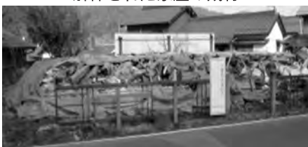
解体された家屋の残材
