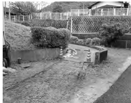
保育園北側にあるスロープ。進入禁止のコーンを設置
