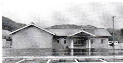
津和野町障害者福祉センター「はなみずき」
