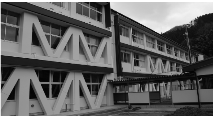
耐震工事が完成した津和野中学校教室棟
