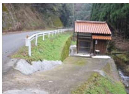
谷川から1.3m 上、平屋建である、 避難経路も急傾斜で危険です。
