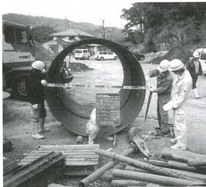
森村公共下水道工事
